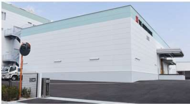
(図表 2) 新設した開発棟・倉庫
