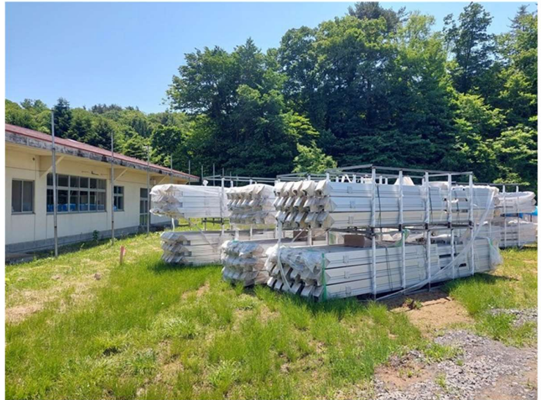
（図表 7）廃校のグラウンドに設置工事中の太陽光発電設備
