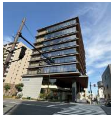
（図表2）新店ビルの外観
